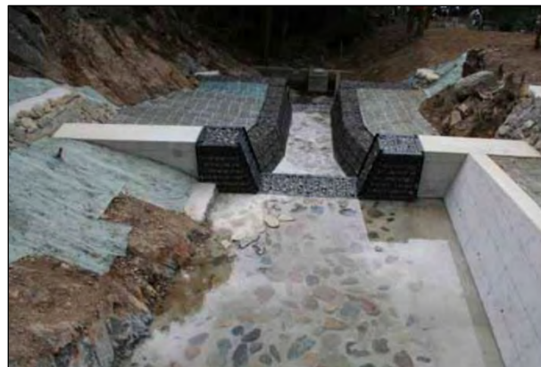
本堤から下流方向 水叩部は石張コンクリート
