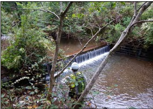
令和元年施設点検時の鋼製スクリーン部
