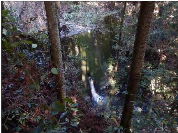
下流域は有効高8m以上の治山ダムが連続する
