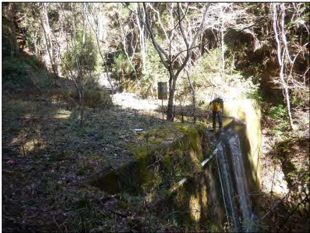
合流部の治山ダム放水路に取水口あり
