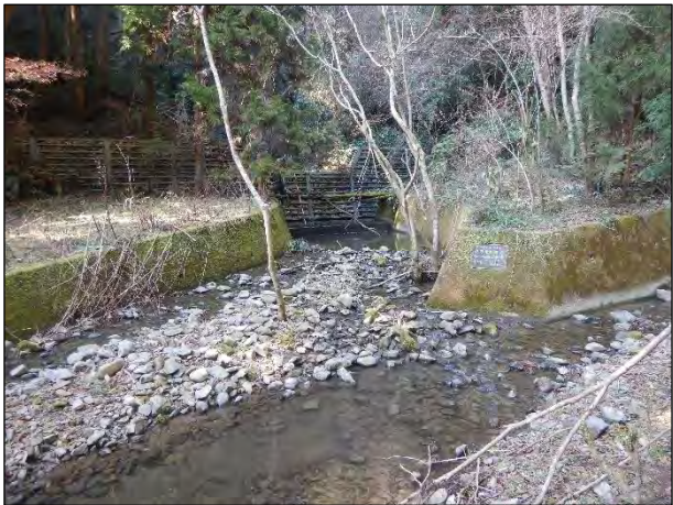
治山ダム堆砂敷から合流部本流側
