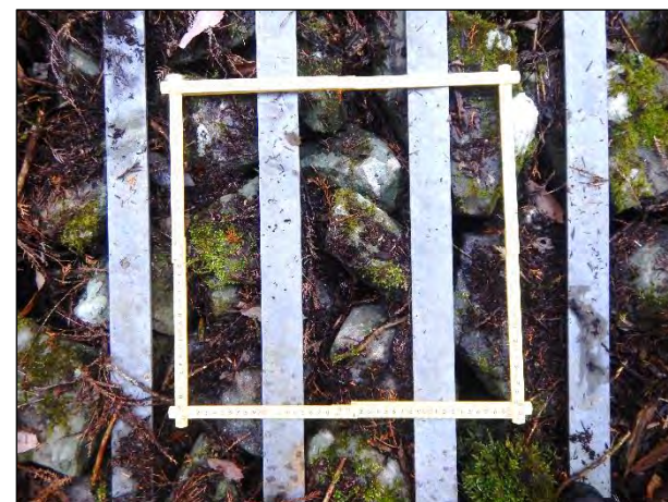
水質保全施設袖部の石礫充填状況
