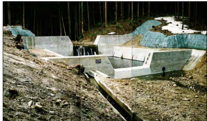
下流右岸から上流方向
