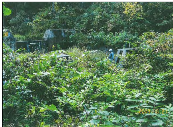
沈砂機能を発揮する空間の状況
