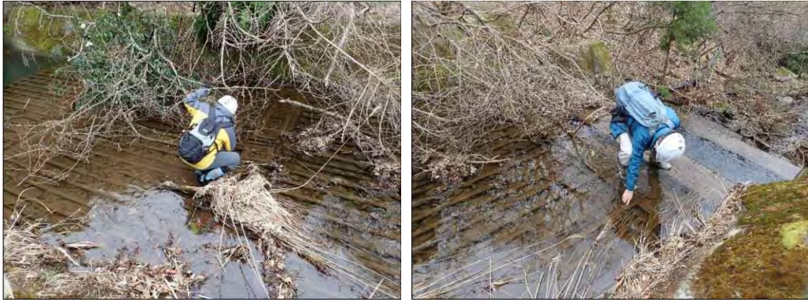
図 4.17 浄化ユニットの引き上げ可能性の確認
