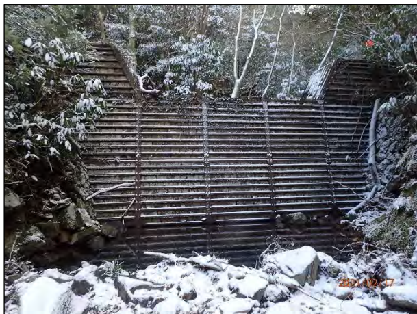
上流施設正面。
