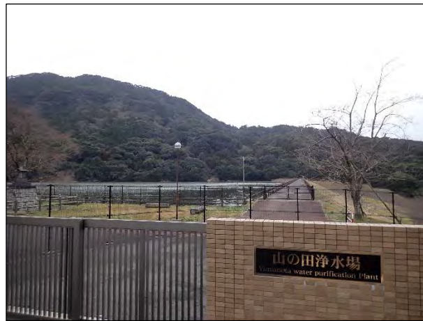
貯水池に隣接する山の田浄水場
