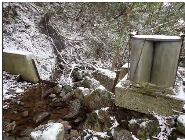
流量観測施設(上流から下流)
