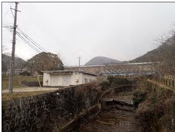
保全対象の貯水池
