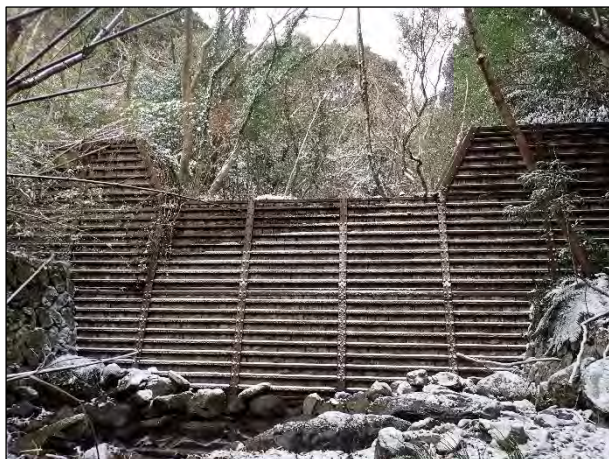
下流施設正面。
