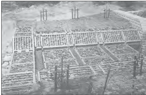
左岸から右岸方向
