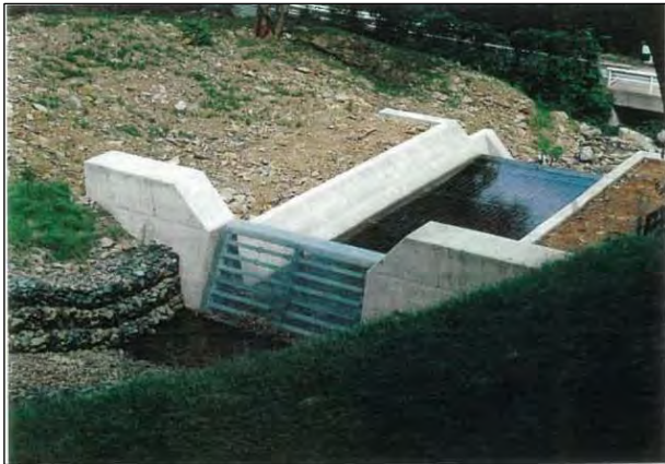
上流から鋼製スクリーンダムと3面張流路部
