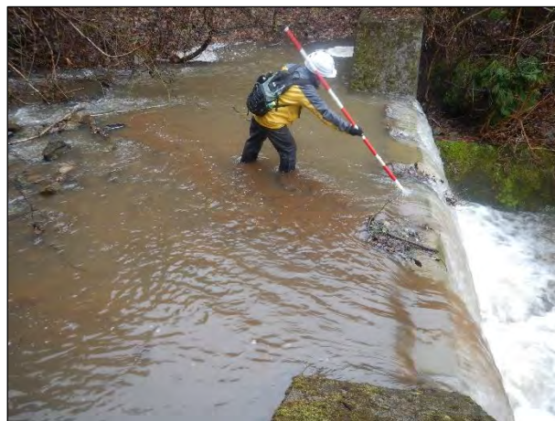
スクリーンダム堆砂敷 容易に濁水が発生。
