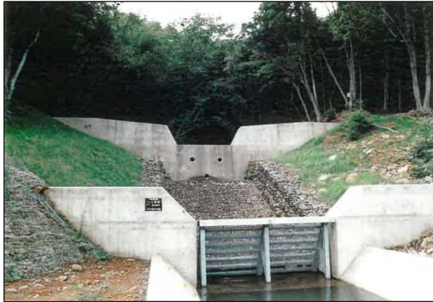
上流の治山ダムとフトンカゴ流路工
