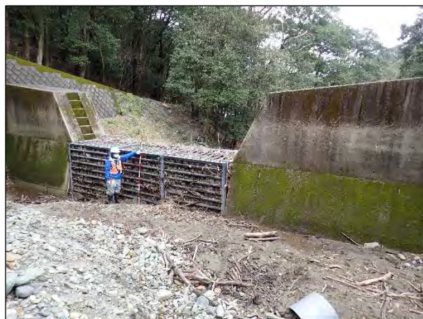
治山ダム透過部。
