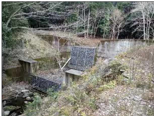
副堤付治山ダム。
