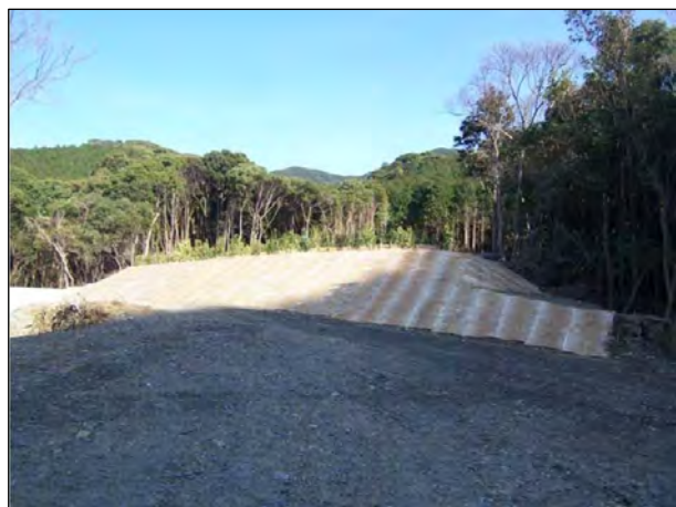
溪流①②間の残土処理状況 緑化対応
