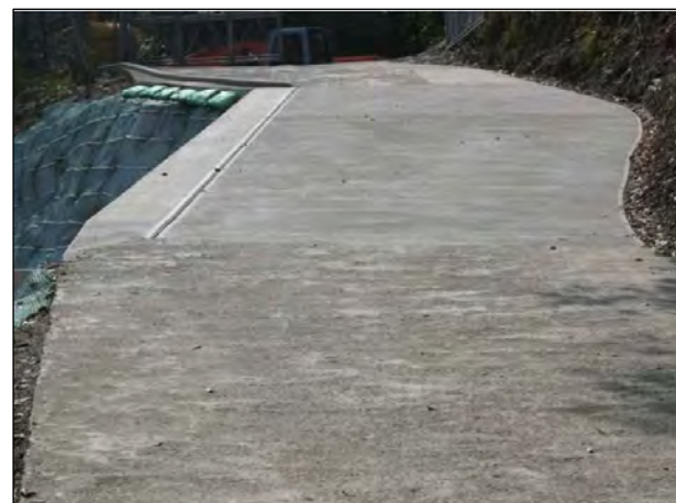
管理道路の復旧状況
