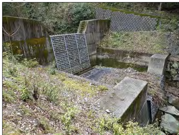
副堤付治山ダム。
