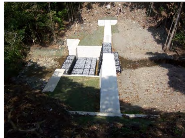
溪流③施設 左岸から右岸
