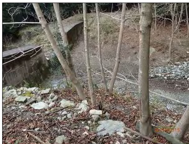
左岸からみた治山ダム堆砂敷。細粒砂の堆積。
