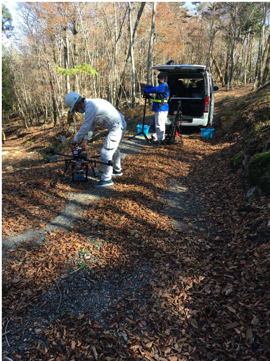
図 2-14 林道・作業道からの UAV 計測の準備状況
