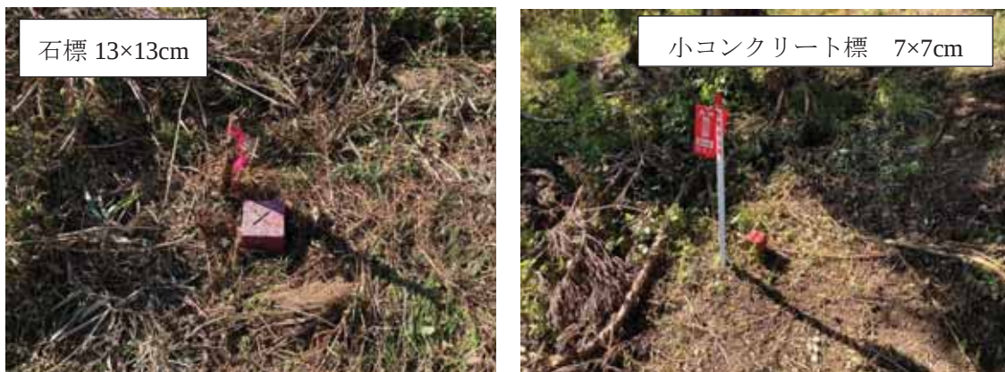
図 3.3-15 境界標の状況
