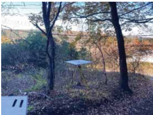
図 3.3-17 対空標識の設置状況 (右側は黄色の反射素材を使用)
