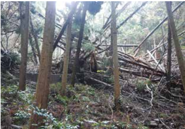
谷止工により土砂・立木を捕捉し、流出拡大を防いだ事例
