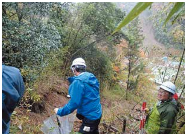
斜面滑落崖の確認
