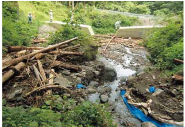
治山施設の設置により土砂や流木を捕捉し、下流林道への被害を防いだ事例
