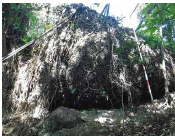
高エネルギー吸収落石防護柵工により転石を含む土砂を捕捉し、下流の商業施設への被害を最小限に防止した事例
