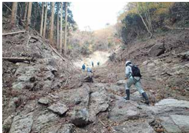
崩壊源頭部付近
