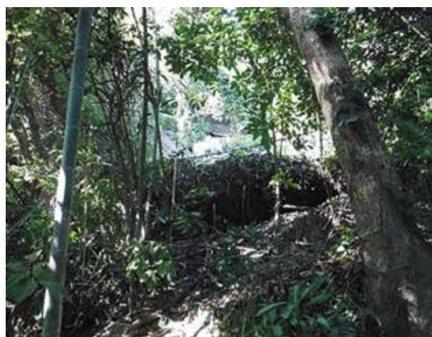
高エネルギー吸収落石防護柵工により転石を含む土砂を捕捉し、下流の商業施設への被害を最小限に防止した事例
