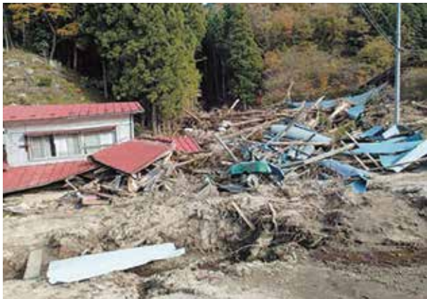
土石等の流出に伴う人家被害
