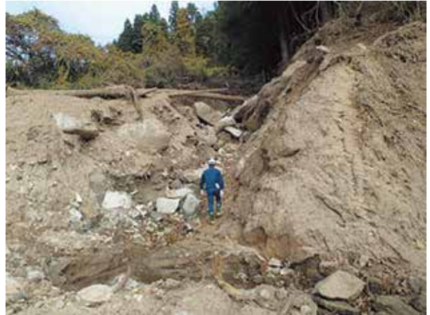
町道付近の土石堆積状況
