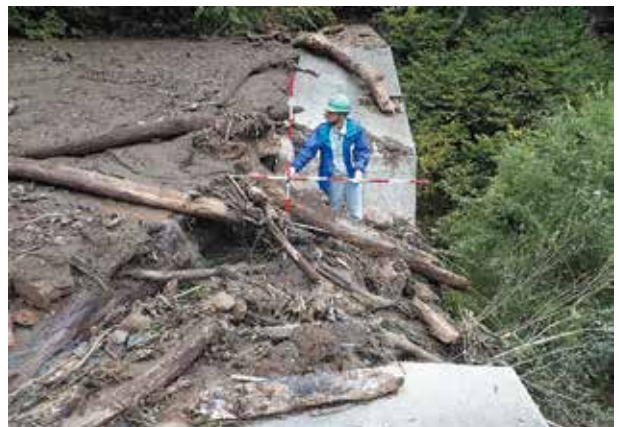
治山ダムにより土砂・流木を捕捉し、下流の災害時要援護者関連施設や人家などへの被害を防止した事例
