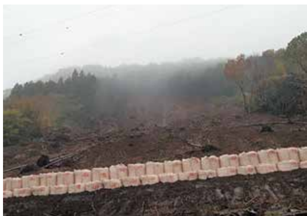
市道より上部全景
