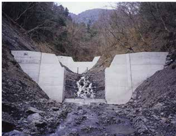
ロープダム工により土砂・流木を捕捉しつつ、流水・小礫は流下させた事例
