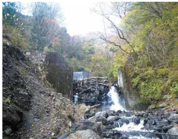
ロープダム工により土砂・流木を捕捉しつつ、流水・小礫は流下させた事例
