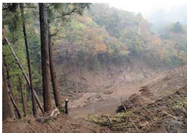
市道より下部の土砂流出状況
