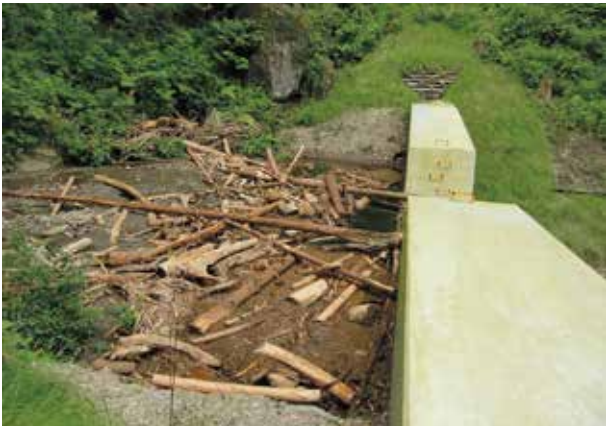
治山施設の設置により土砂や流木を捕捉し、下流林道への被害を防いだ事例
