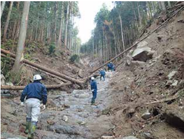
流下区域の溪床の露岩と侵食状況
