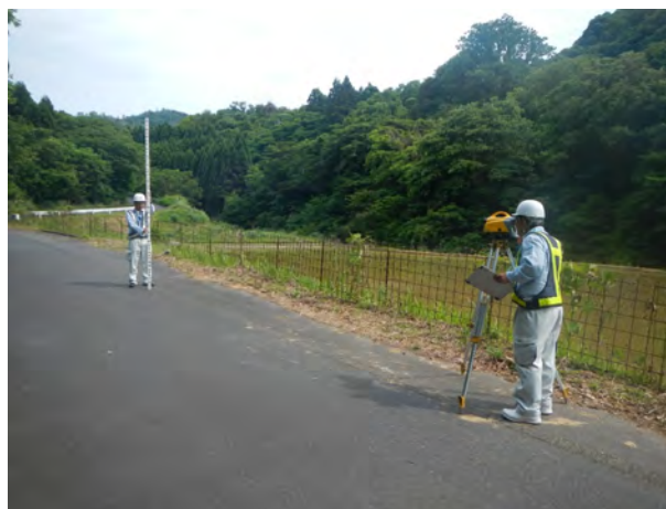
図 3.4.2 水準測量の実施状況
