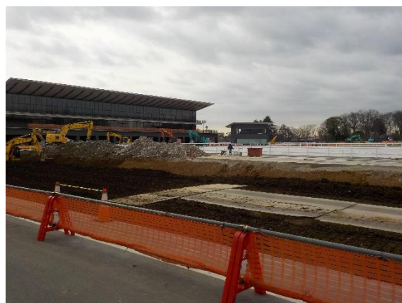
スタジアム(解体工事中)
