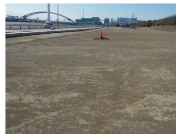
駐車場前植林地 (新設既舎撤去)
