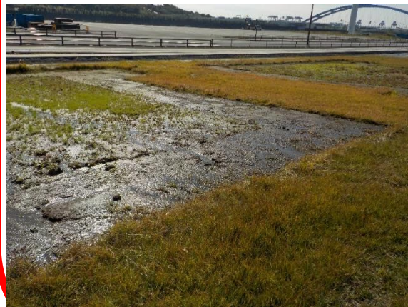
駐車場前植林地(新設既舎跡)
