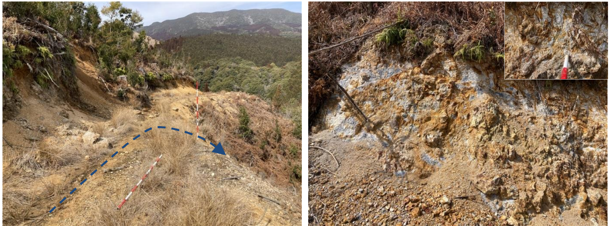
写真 3.4 崩壊地②集材路からの流水跡（左図）と粘土化した崩壊面（右図）
