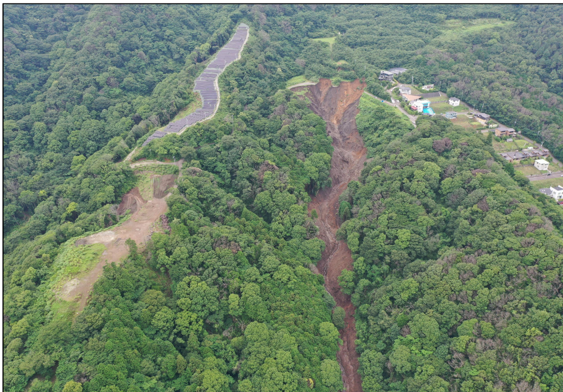
写真 2.1 崩壊源頭部全景
