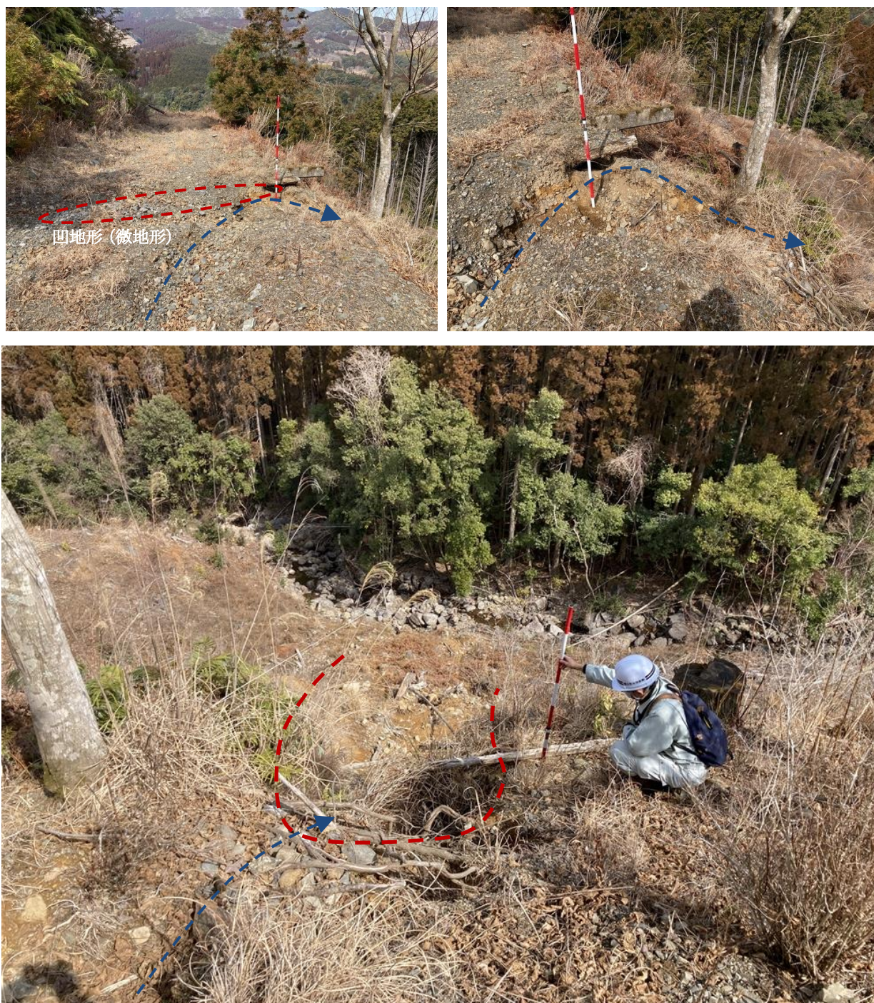
写真 3.7 上部作業道から崩壊地への雨水流入の痕跡
