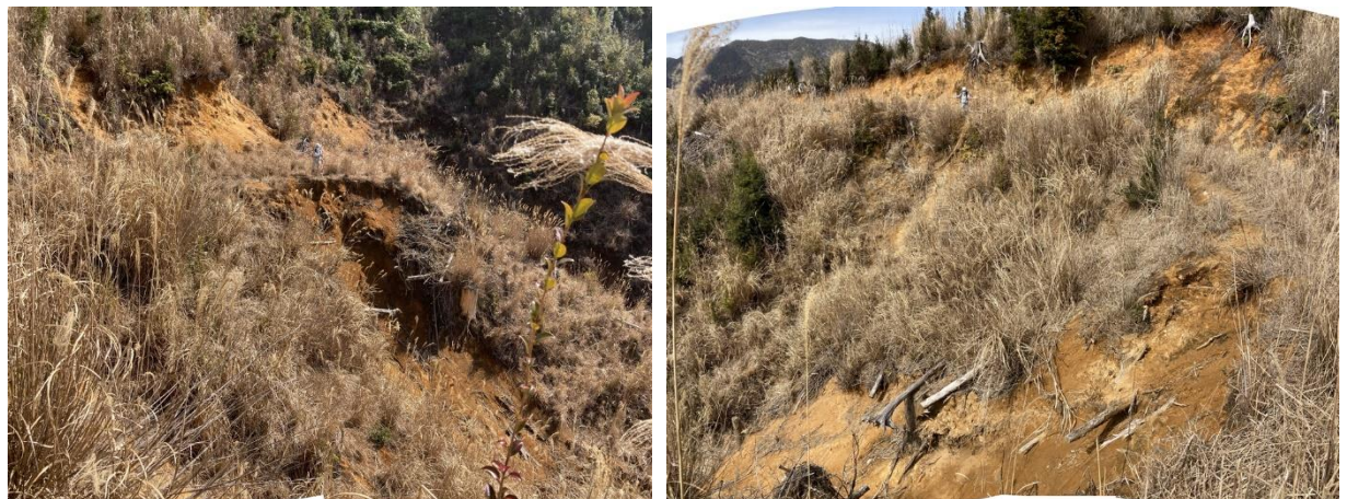
写真 3.9 崩壊地⑥～⑧の状況
