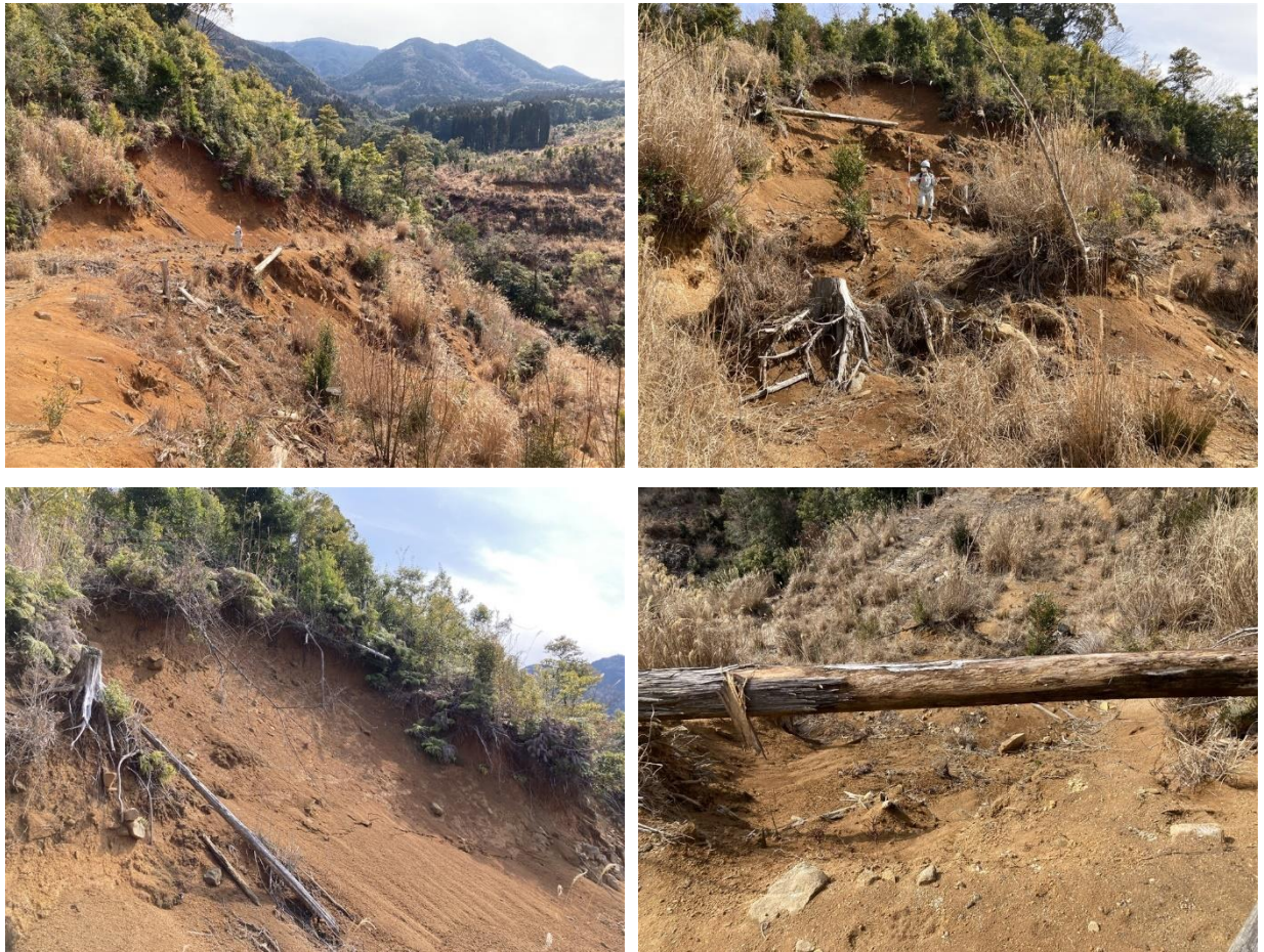
写真 3.8 崩壊地⑤の状況
