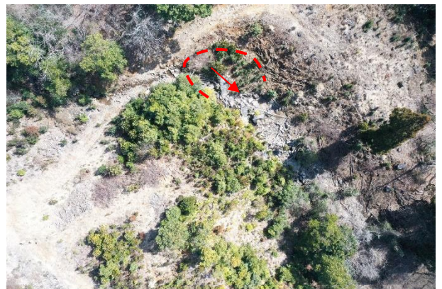
写真 3.12 崩壊地⑩の状況
