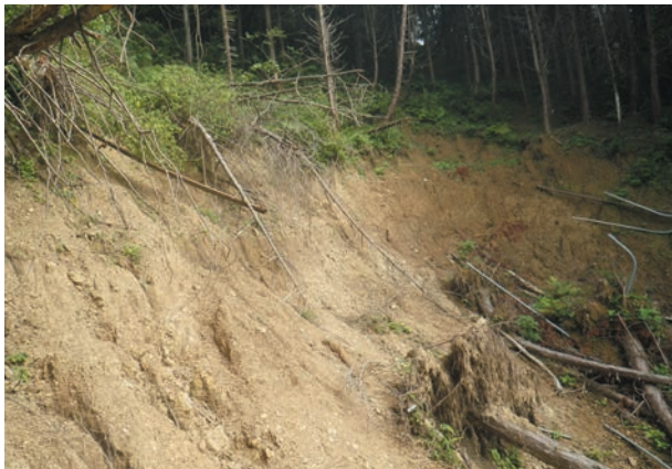
崩壊地源頭部
