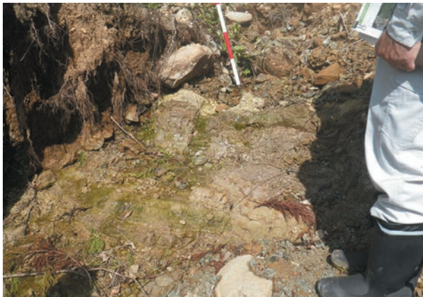
崩壊地内に見られる湧水
