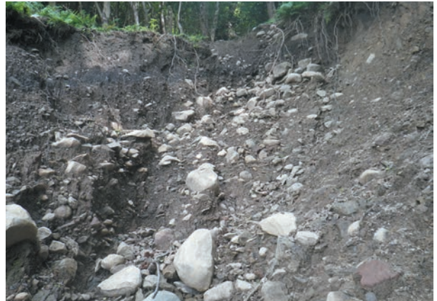
崩壊地源頭部
