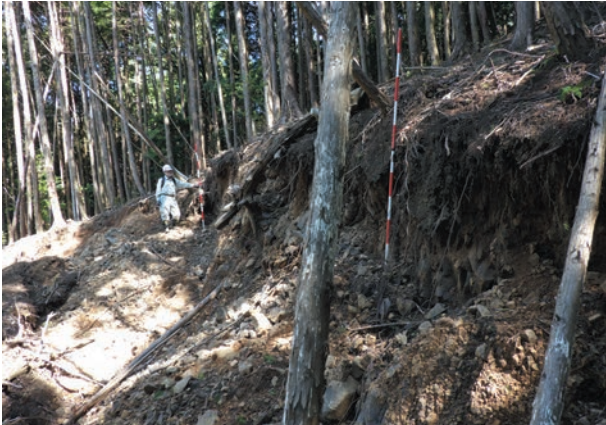
上部斜面に見られる連続する亀裂
