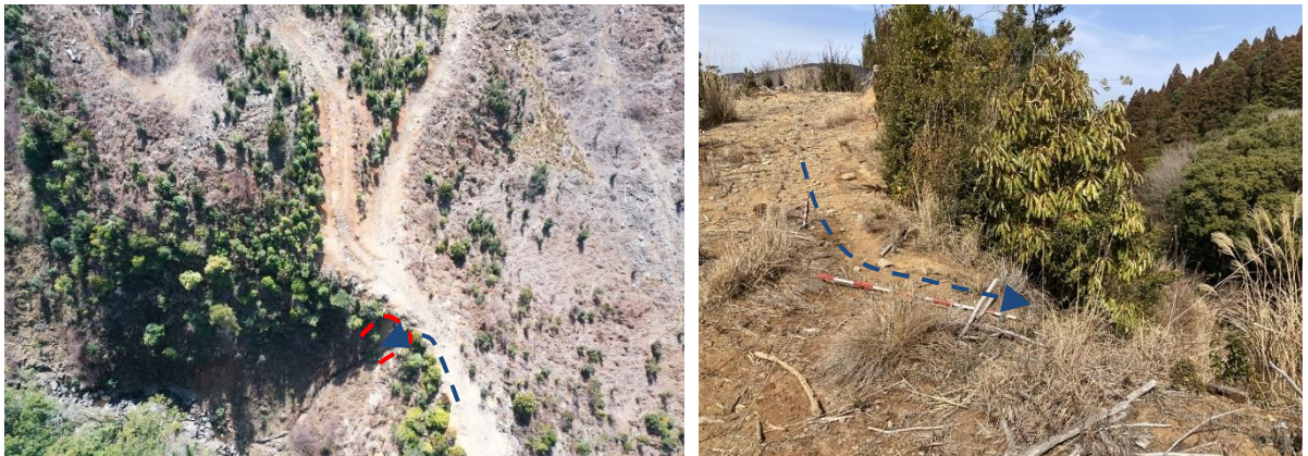
写真 3.14 崩壊地⑫の状況（集材路からの流水跡が見られる）
