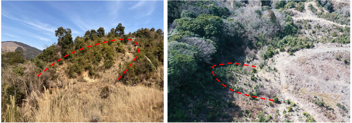
写真 3.13 崩壊地⑪の状況
