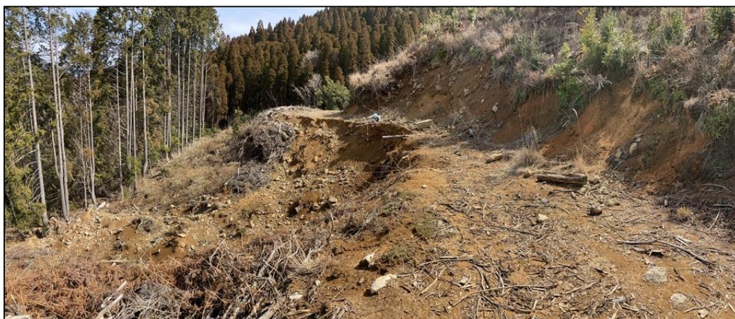
写真 2.3 現地調査箇所の事例（崩壊地③）
