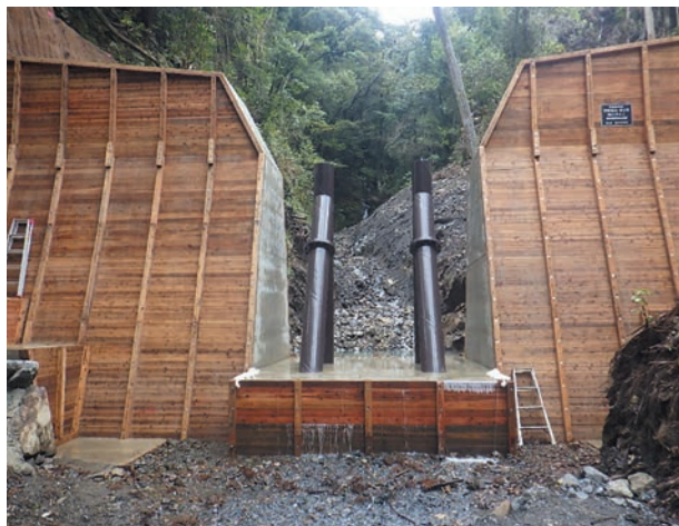
流木捕捉式ダムが流木及び土砂を捕捉した事例
