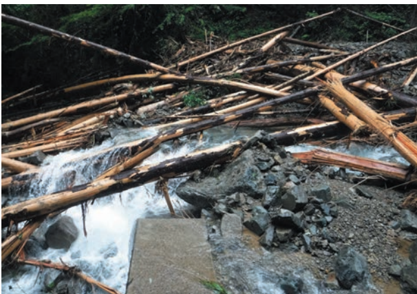
治山ダムが溪流の勾配を緩やかにしていたため流木流出を防止した事例
