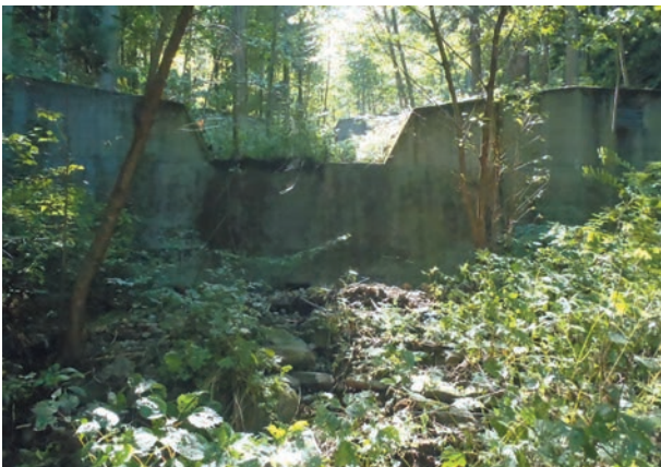
治山ダムが溪流の勾配を緩やかにしていたため土砂や流木流出を防止した事例
