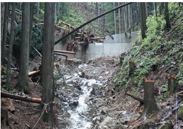
治山ダムが崩壊地から流れ出た土砂や倒木の流出を防止した事例
