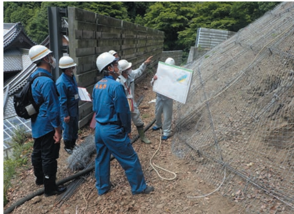
山地災害危険地区の点検（兵庫県）
