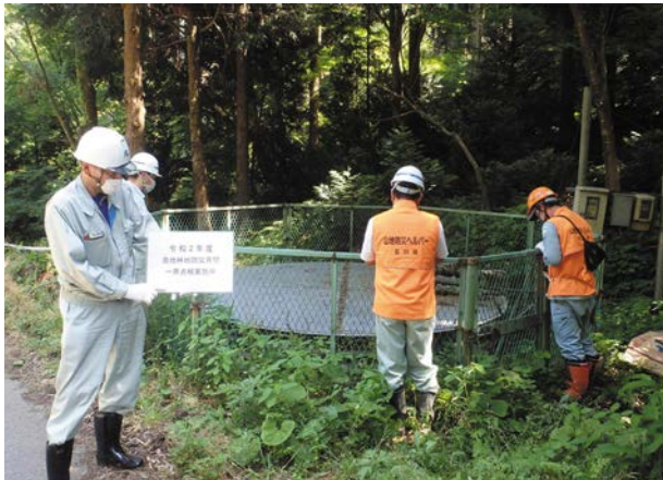
点検状況（石川県）
