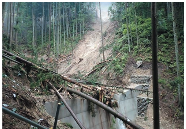
治山ダムが崩壊地から流れ出た土砂や倒木の流出を防止した事例
