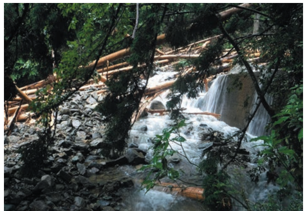
治山ダムが溪流の勾配を緩やかにしていたため流木流出を防止した事例
