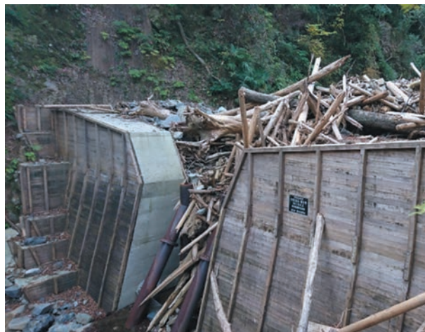
流木捕捉式ダムが流木及び土砂を捕捉した事例
