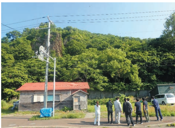
危険地区及び治山施設点検（北海道）
