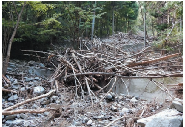
治山ダムが溪流の勾配を緩やかにしていたため土砂や流木流出を防止した事例
