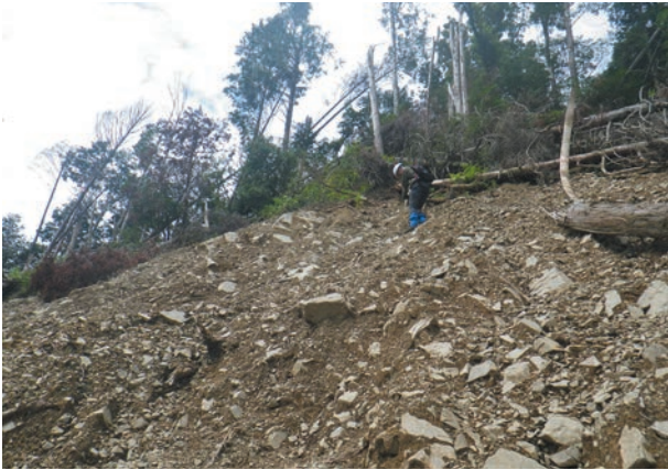
崩壊地上部の状況
