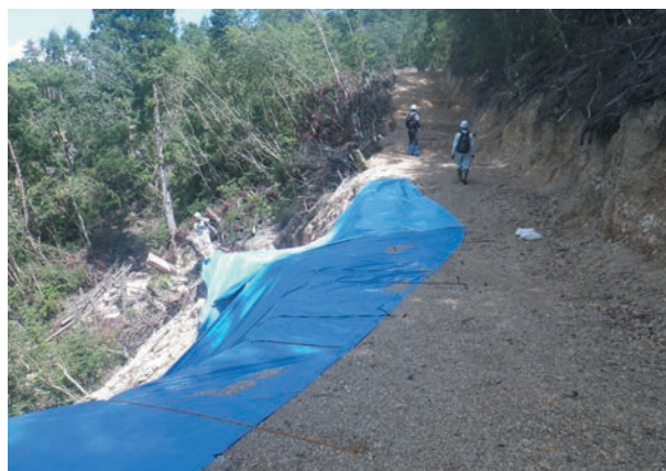
崩壊地上部の作業道
