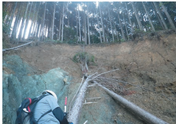
崩壊地源頭部
