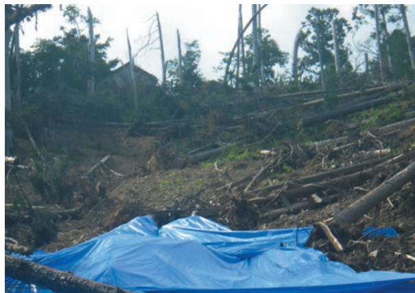
崩壊地上部と風倒木の状況
