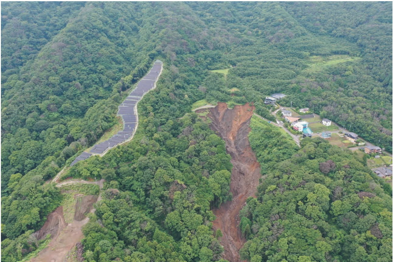
崩壊源頭部全景
