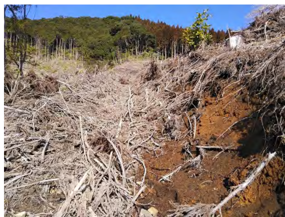
C 区の作業道の法面。落差がある箇所を地拵え機械が迂回する必要がある
