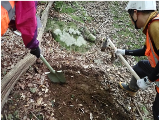
露出した巨礫の手前で断面を作成
