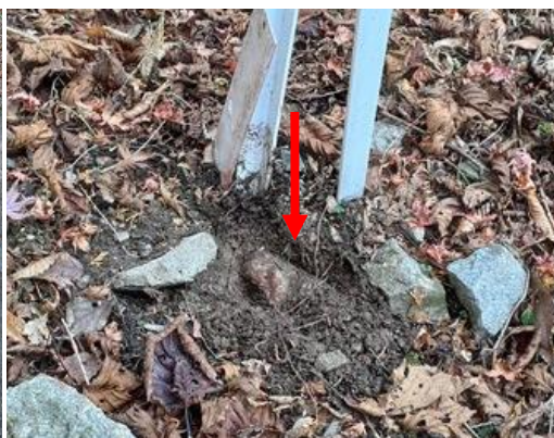
図 4.4-3 破損した杭
