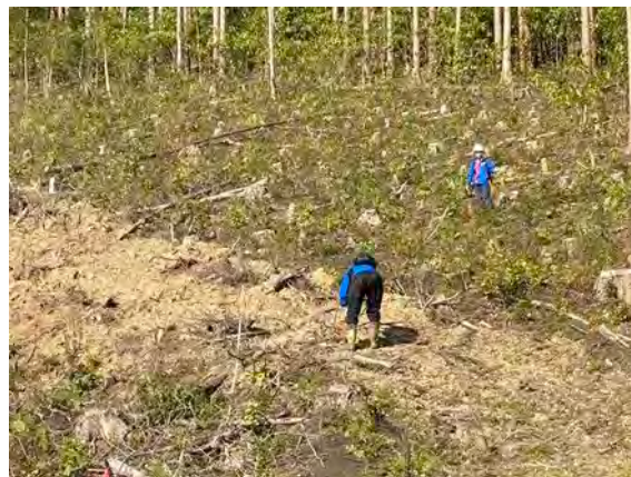
植栽列の標示作業（A等高線区）
