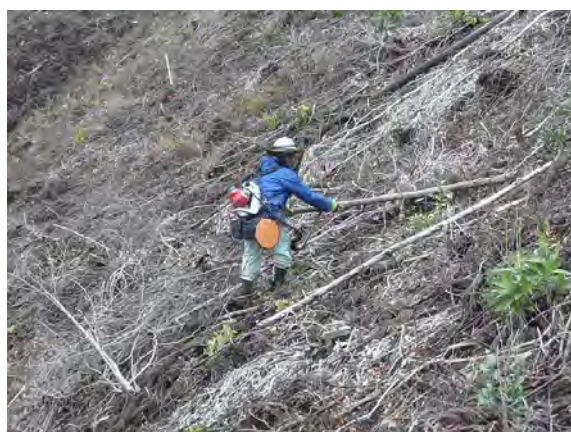
細分化した支障木は適宜整理
