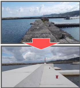
漁港施設の長寿命化対策
