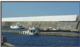
防波堤の高上げによる越波対策
