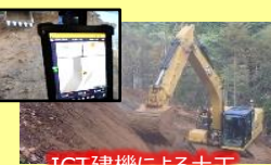
ICT建機による土工
