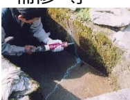
水路のひび割れ補修
