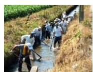
水路の泥上げ
