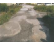
農道の窪みの補修
