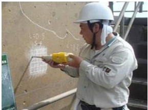
老朽化した施設の機能診断
