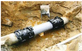
漏水防止のための整備
