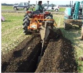
暗渠排水の整備
