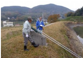
ため池の現地パトロール
