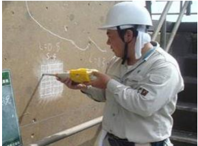
老朽化した施設の機能診断
