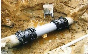
漏水防止のための整備
