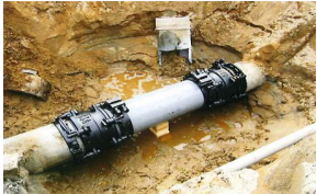
漏水防止のための整備
