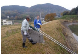
ため池の現地パトロール
