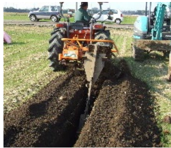
暗渠排水の整備
