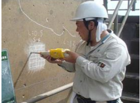
老朽化した施設の機能診断
