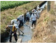
水路の泥上げ
