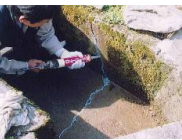
水路のひび割れ補修
