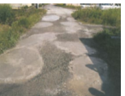
農道の窪みの補修
