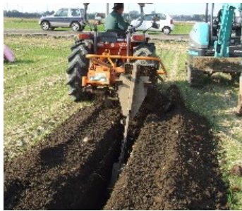
暗渠排水の整備
