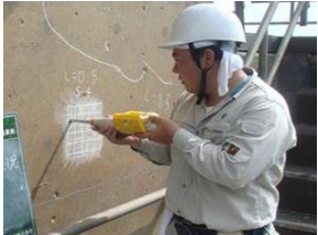
老朽化した施設の機能診断
