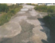
農道の窪みの補修
