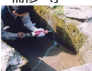
水路のひび割れ補修
