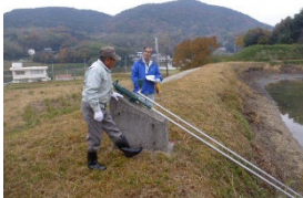
ため池の現地パトロール
