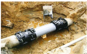
漏水防止のための整備
