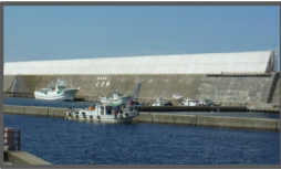
防波堤の高上げによる 越波対策
