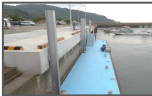
陸揚げの軽労化に資する 浮体式係船岸の整備
