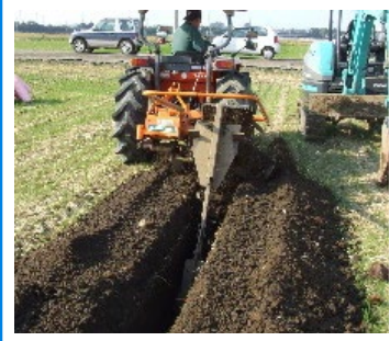
暗渠排水の整備
