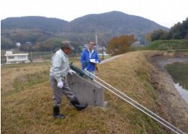
ため池の現地パトロール
