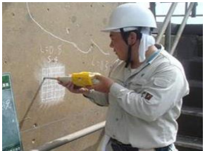
老朽化した施設の機能診断
