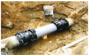
漏水防止のための整備
