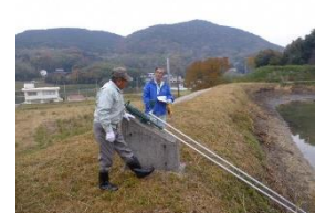
ため池の現地パトロール
