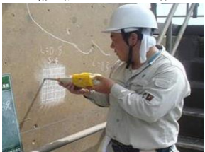
老朽化した施設の機能診断
