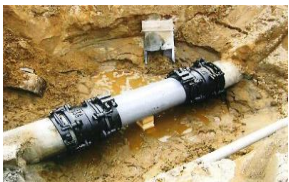
漏水防止のための整備
