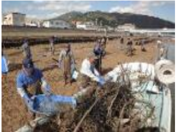
災害時の流木の回収・処理
