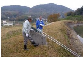
ため池の現地パトロール
