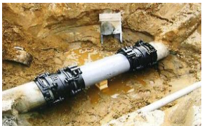
漏水防止のための整備
