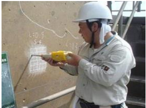
老朽化した施設の機能診断
