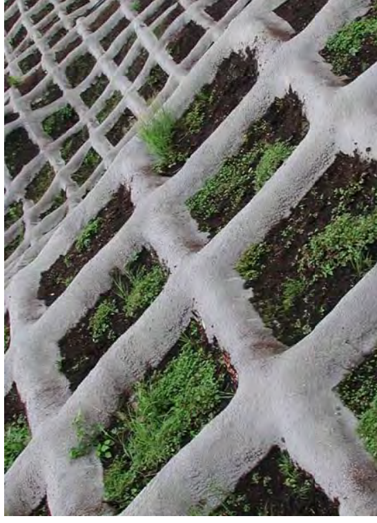
施工後の発芽状況
