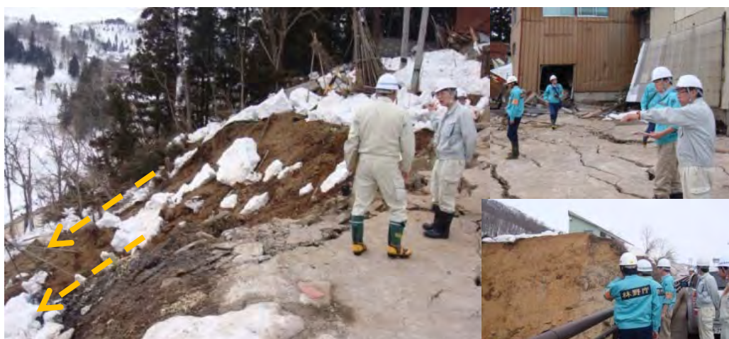
地震により発生した崩壊箇所を緊急に復旧整備
