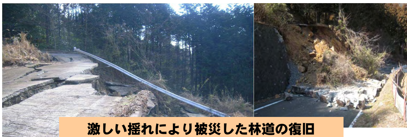
被災した防潮工を復旧
