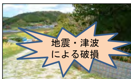
侵入防止柵の復旧
