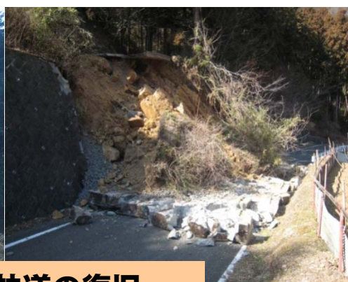
激しい揺れにより被災した林道の復旧
