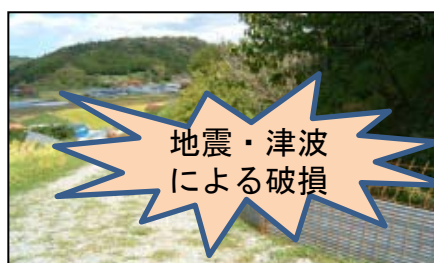
侵入防止柵の復旧
